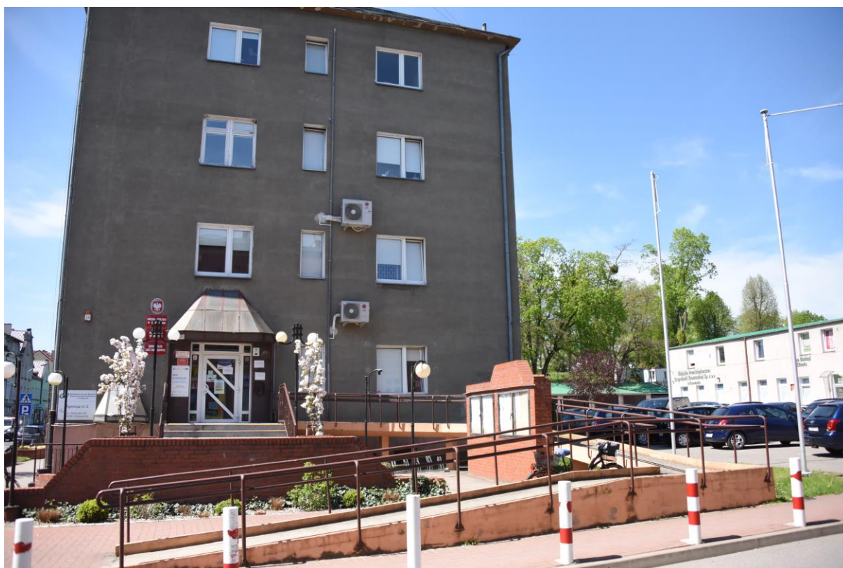
Budynek urzędu miasta widok od strony ulicy Wolności
