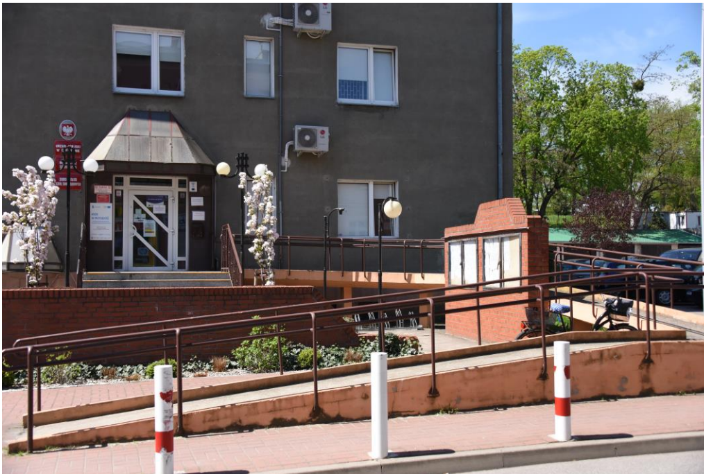
Wejście główne z podjazdem i dzwonkiem
